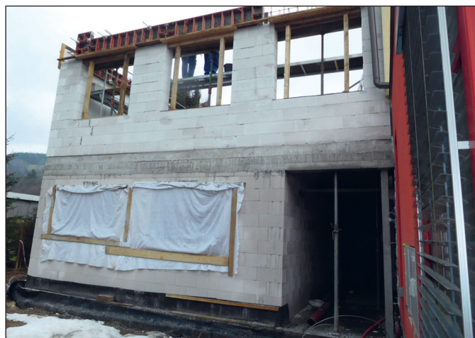
Pokračování přístavby tělocvičny – stav ze začátku února 2018
